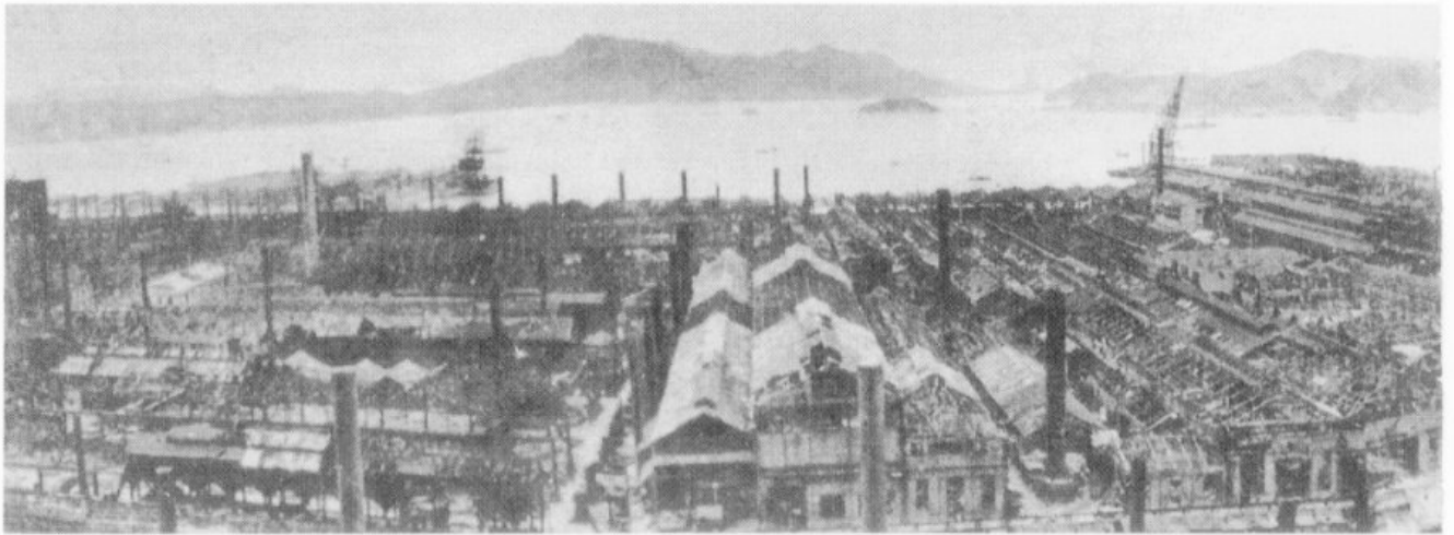
廃虚となった呉海軍工廠。鉄骨と一部の建物だけ残った。右端に見える200トンクレーンは現在もある。
